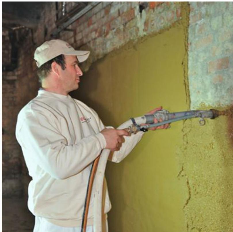
Ansetzen der Dämmplatten mit Lehmklebe- und armierungsmörtel. Anschließend werden die Platten verdübelt. Dabei werden die Platten noch einmal in den noch feuchten, also plastischen, Lehmklebemörtel hineingezogen, um die Hohlraumfreiheit zu gewährleisten.
