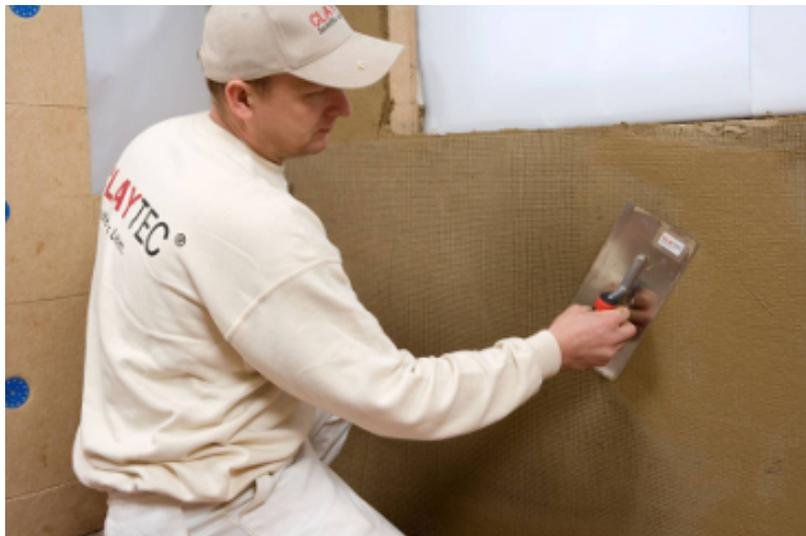
Nach der Trocknung dieser Lage folgt eine zweite Lage Lehmfeinputz also des gleichen Materials wie die erste Lage. Anschließend wird die Wand gestrichen. Tapeten wären grundsätzlich auch möglich, sind hier aber eher unüblich.
